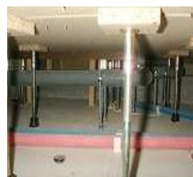
点検口から床下をカメラで撮影
