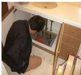
洗面台下の点検口
